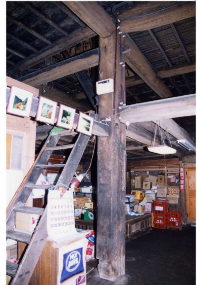
柱と梁でがっしりと組んだ空間
