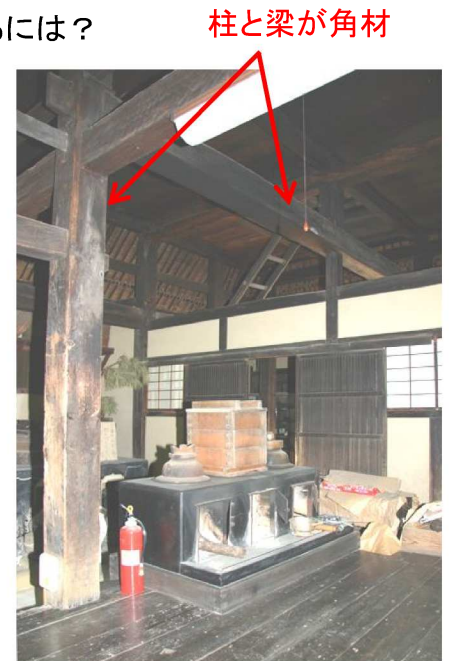
大黒柱はない
