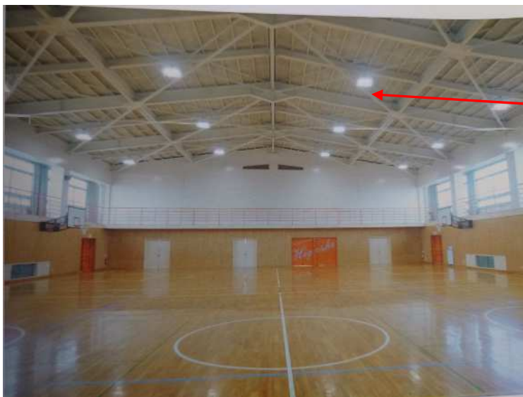
屋根鉄骨補強
