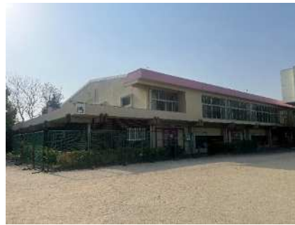
屋内運動場（体育館）（東面）
