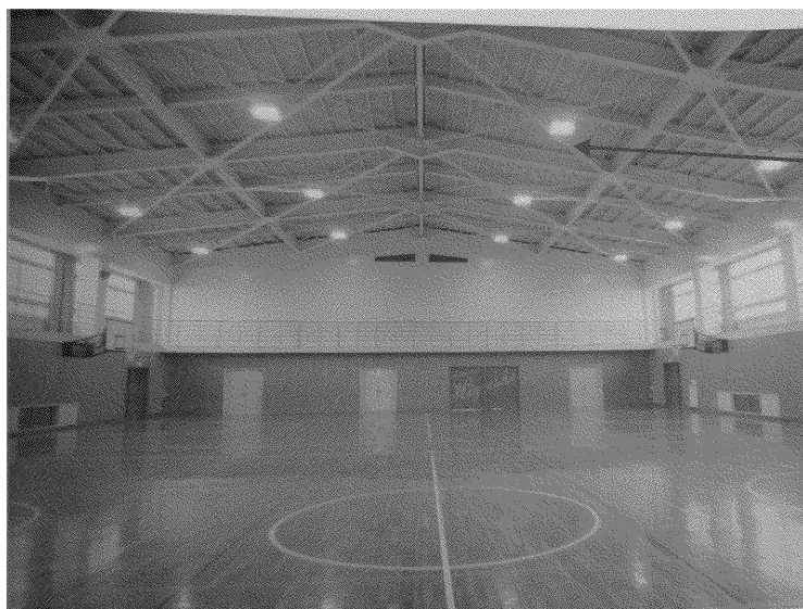
屋根鉄骨補強
