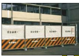
仮囲い ガードフェンス
