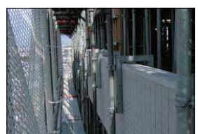
跳ね出し足場
