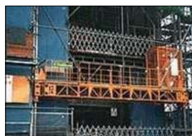
工事用エレベーター
