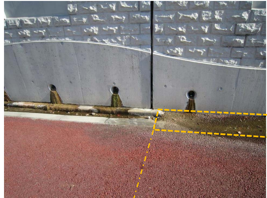
現況部分 ← ⊙ → 工事部分
