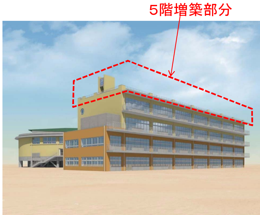
既設普通教室棟(4階建)
