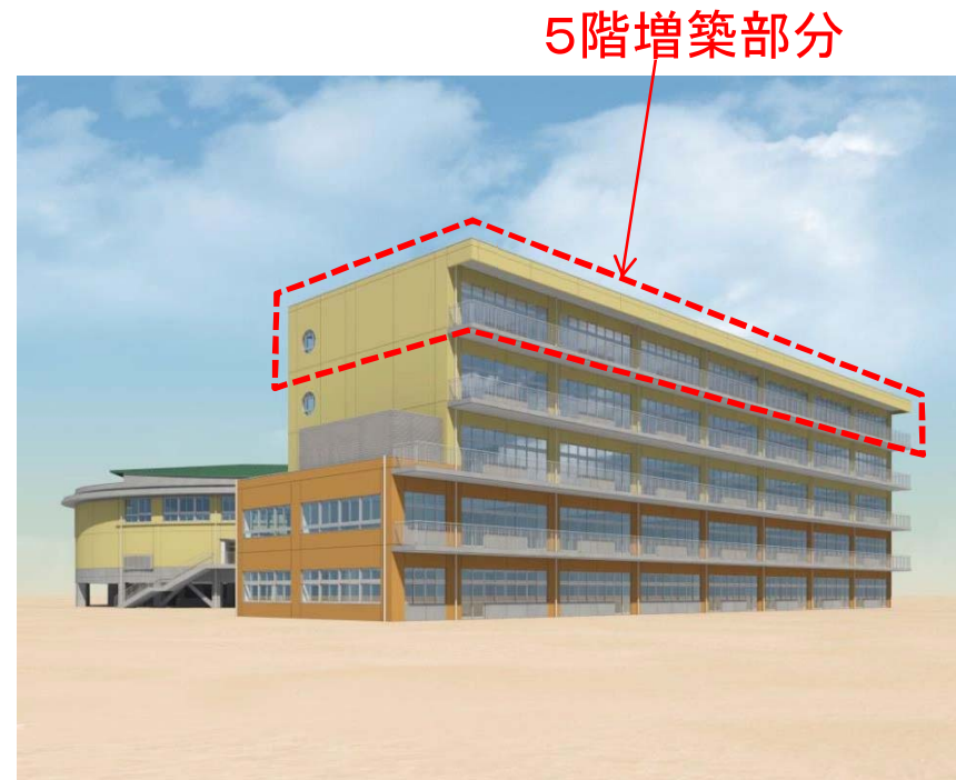
増築後普通教室棟(5階建)
