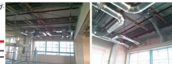
ワークスペースに蓄熱された熱を夜間の外気で冷却することができる熱排気ファンを設置。
