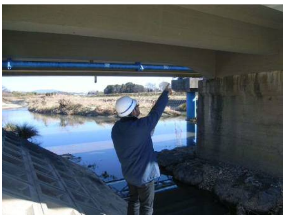
写真-3.3 職員による点検状況①
