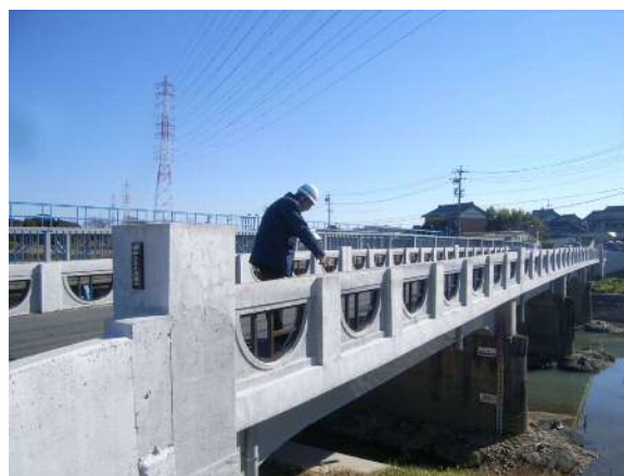
写真-3.4 職員による点検状況②
