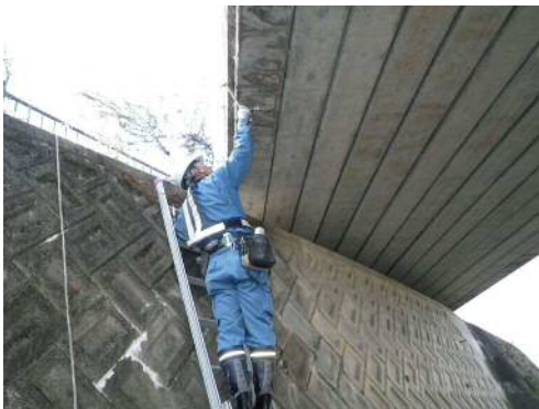
写真-3.1 専門業者による点検状況①
