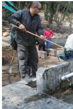
↑汚れていた洗い場もきれいに
