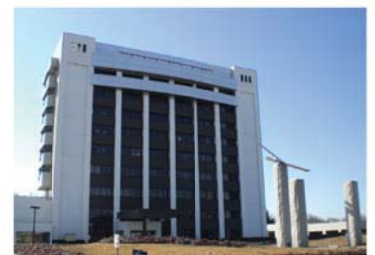
農業総合試験場本場 中央研究棟
