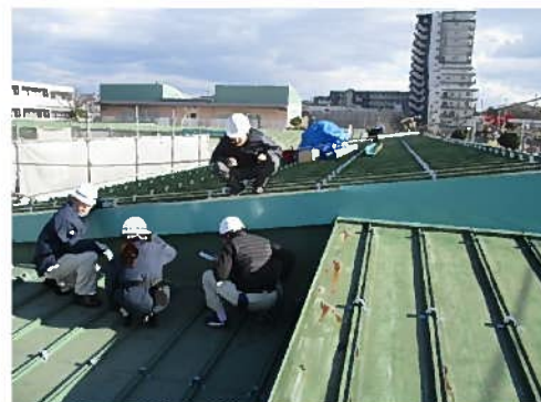
屋根点検の様子
