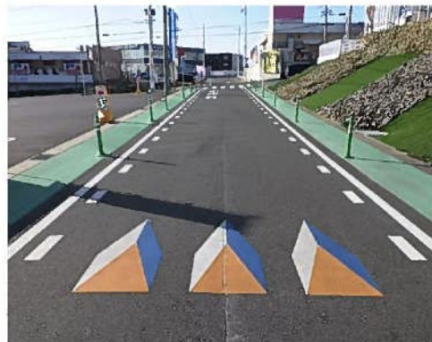
カラー塗装を実施した道路
