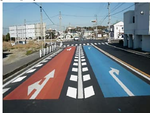
カラー塗装を実施した道路
