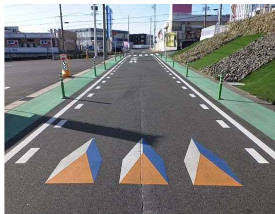
カラー塗装を実施した道路
