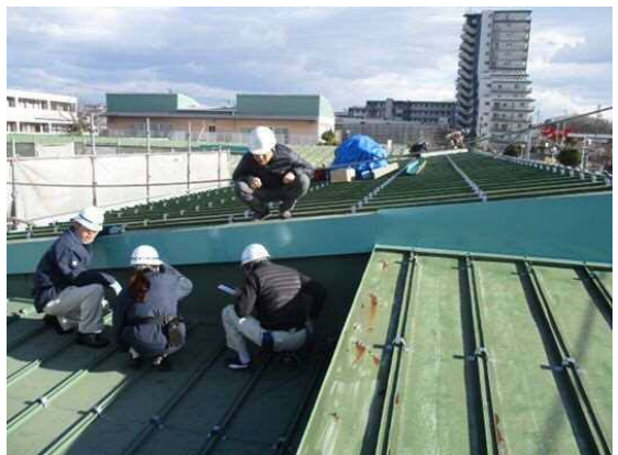
屋根点検の様子
