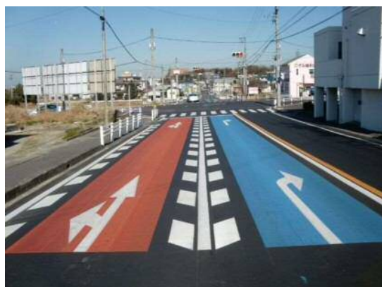
カラー塗装を実施した道路
