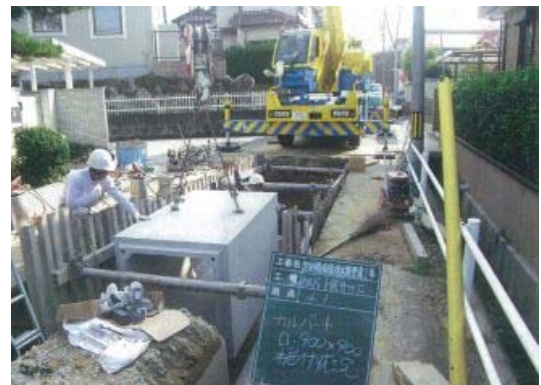
排水路整備工事の様子（イメージ）
