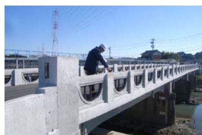
橋梁の点検作業の様子
