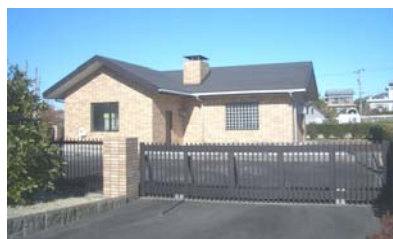
農業集落排水汚水処理施設
