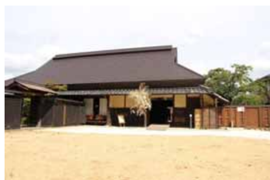
旧市川家住宅の全景
