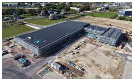
道の駅現場状況写真(11月7日現在)
