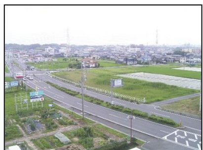
日進消防署より計画地を望む
