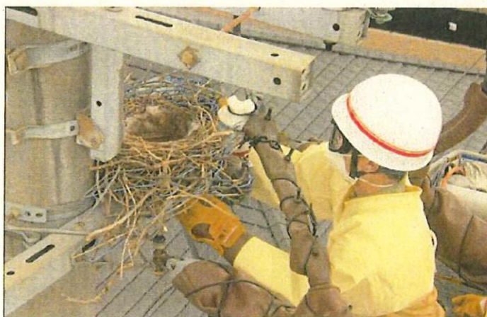
撤去作業中の様子
