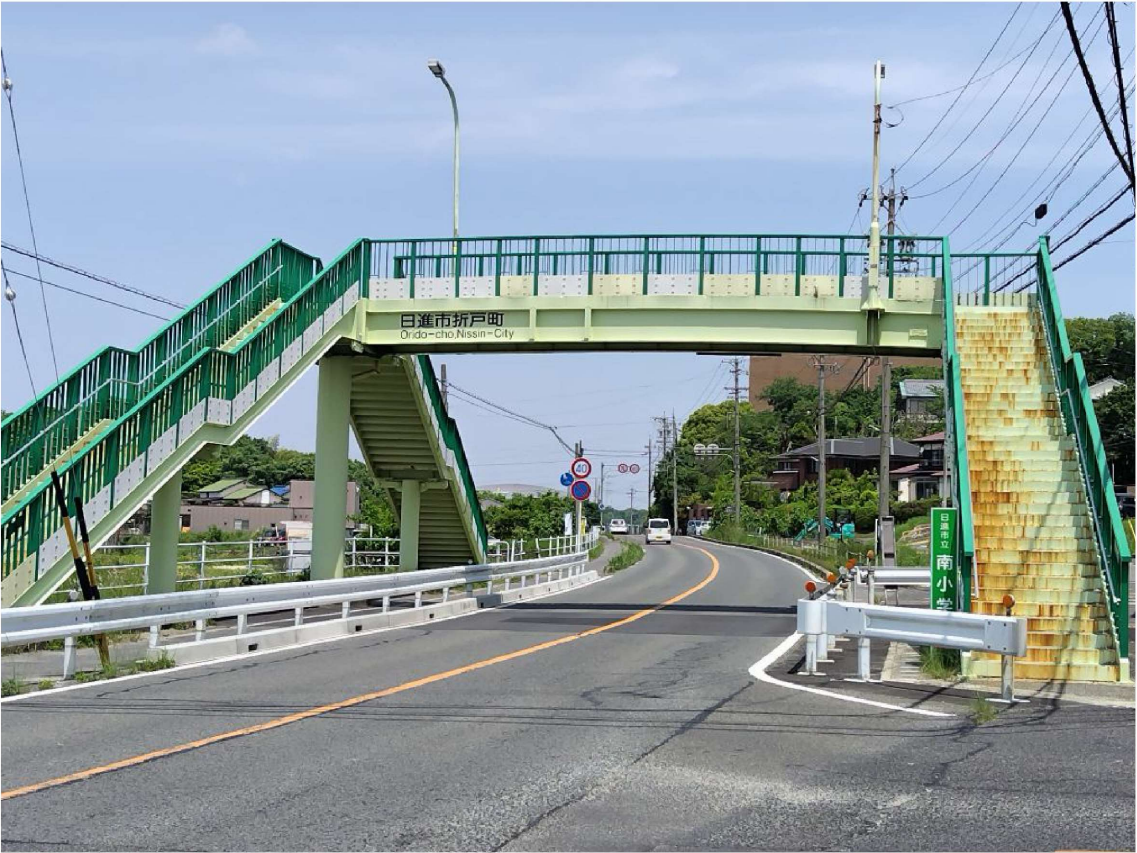
無名歩道橋（南側）
