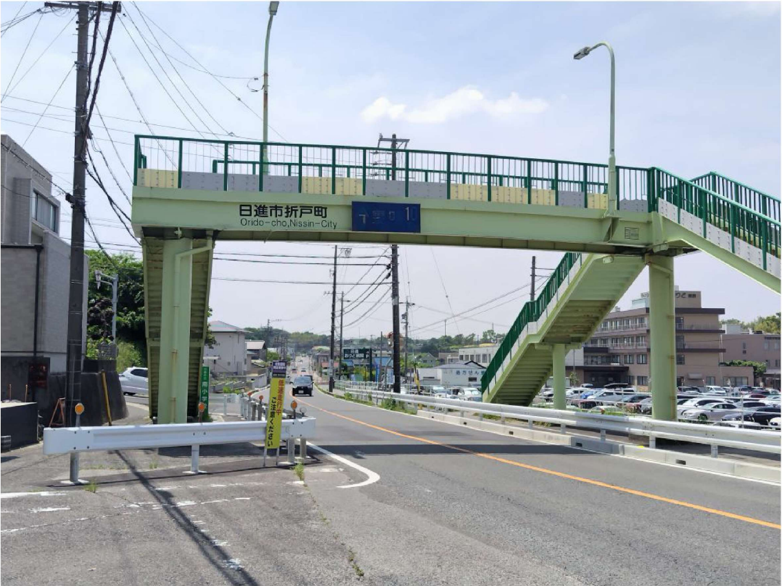
無名歩道橋（北側）
