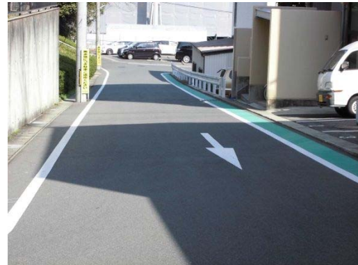
(通学路カラー舗装の例 (日進市))
