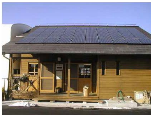
(太陽光パネル (中央環境センター))
