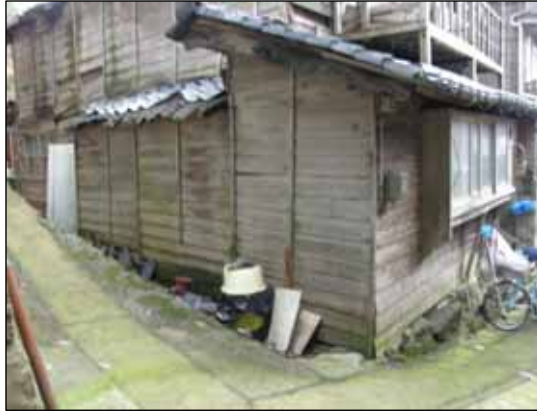
外壁が裸木造の例
