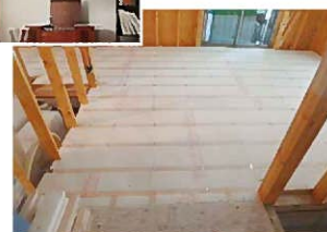
左／内窓の設置 下／床下の断熱改修
