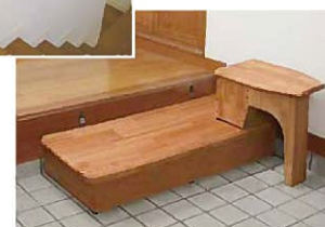
左／階段への 手すりの設置 下／段差の縮小
