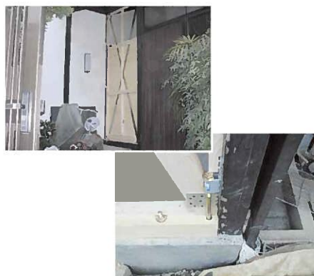
上／筋交いの補強 下／ホールダウン金物
