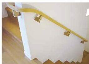
左／階段への 手すりの設置 下／段差の縮小
