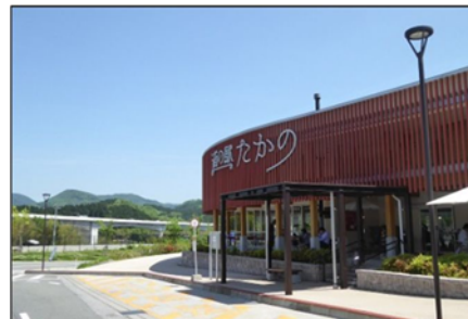
道の駅 たかの (広島県庄原市) 出典：道の駅たかの HP
