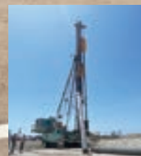
5月10日時点の 道の駅工事状況
