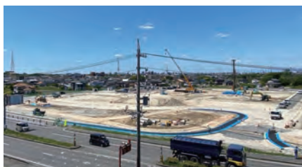
現場状況(令和6年5月現在)
